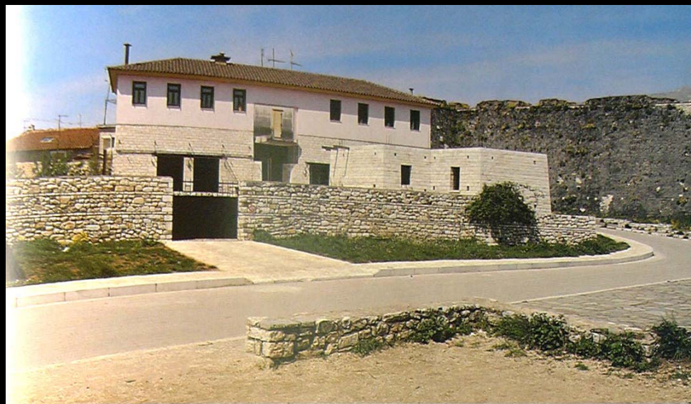
ΓΕΝΙΚΗ ΑΠΟΨΗ ΤΗΣ ΝΟΤΙΑΣ ΠΛΕΥΡΑΣ
