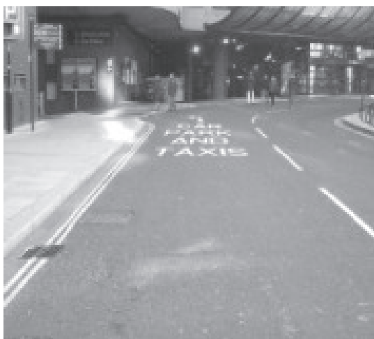
εικ. 11 Η παραμόρφωση των σημάτων στο οδόστρωμα διευκολύνει την ανάγνωση από τη θέση του οδηγού
